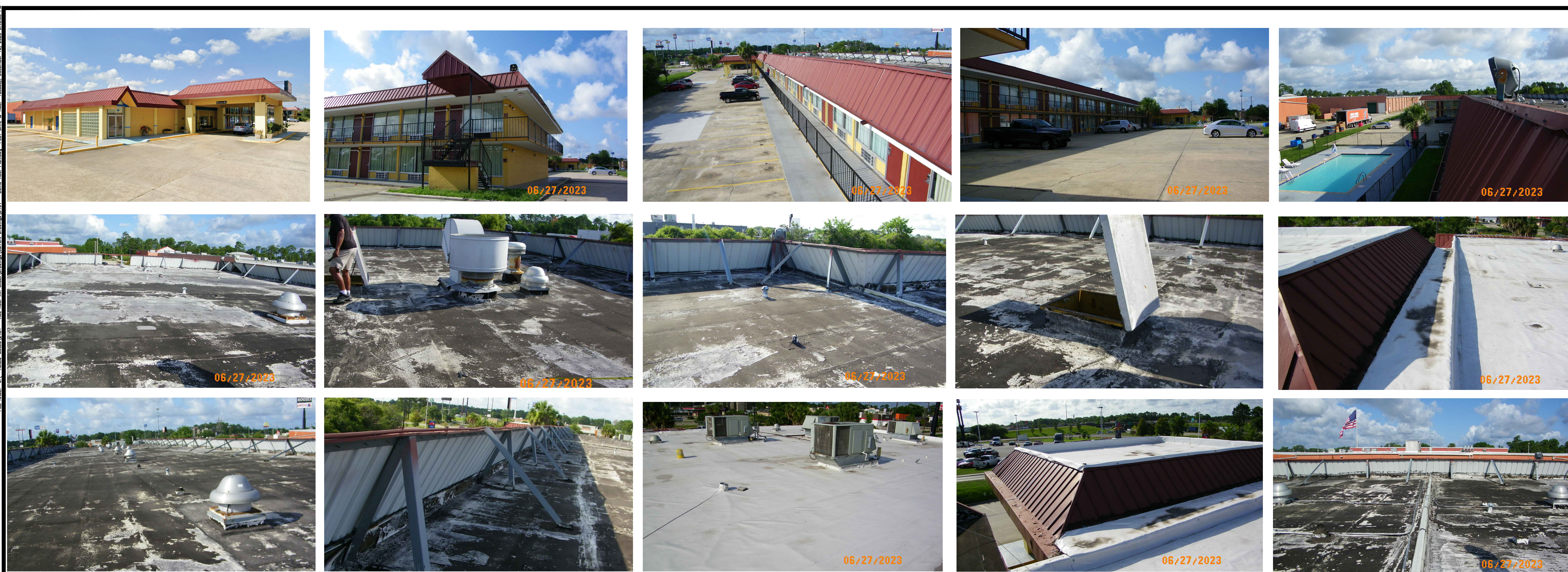
1 EXISTING ROOF-PICTURES FOR REFERENCE SCALE: N.T.S.
