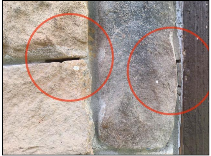
27. Mortar deterioration
