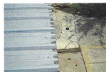
Roof - Rear Edge
