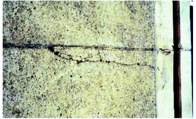
Fig. 2.2.13.1—Joint spall.
