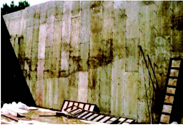
Fig. 2.3.5—Cold-joint line.
